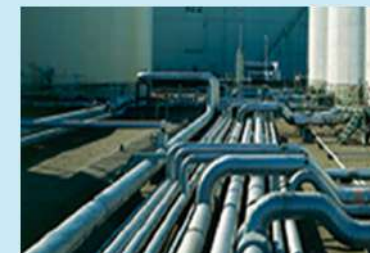
パイプライン
